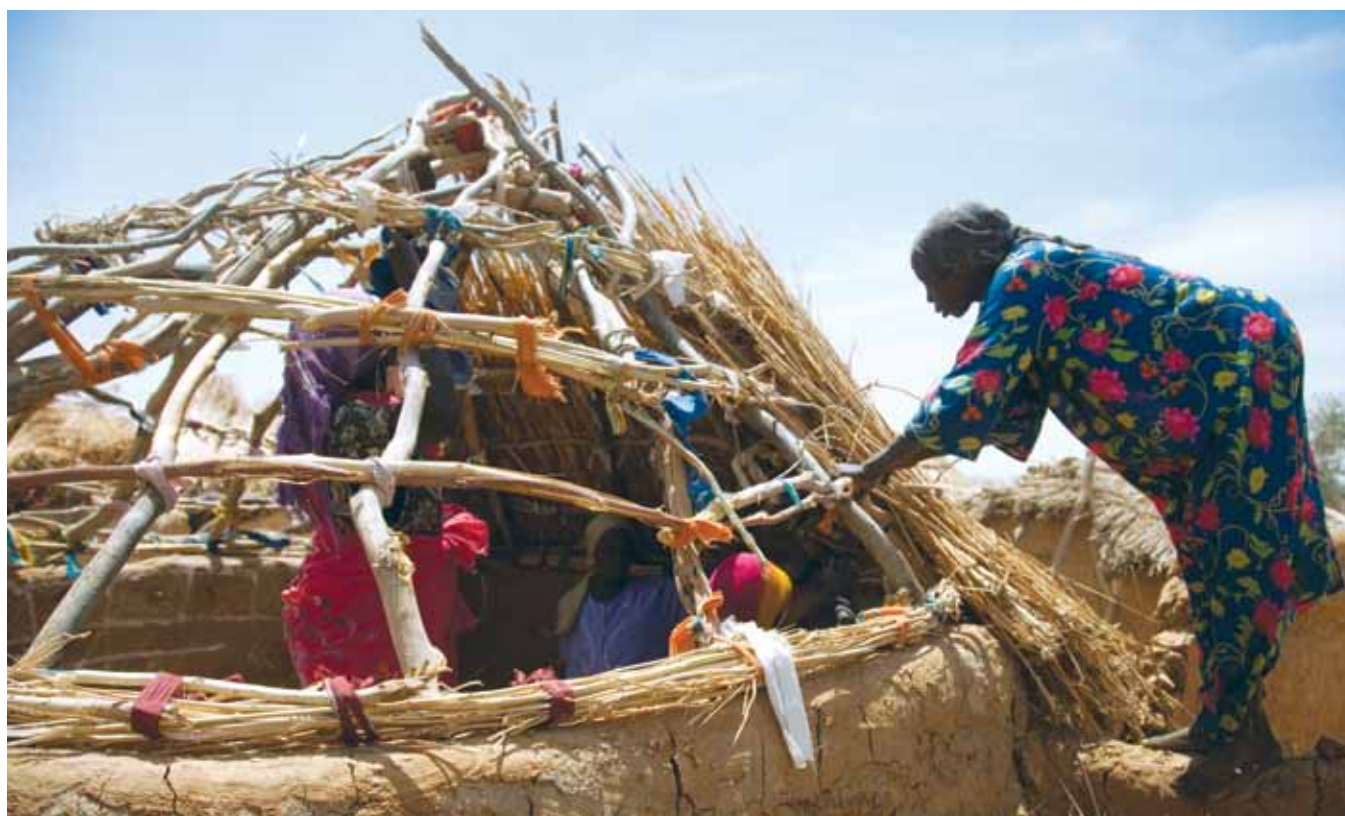
📷 Ciad: costruzione del tetto di una stanza nel campo per rifugiati di Kounougou. (Don Doll SJ/JRS)
